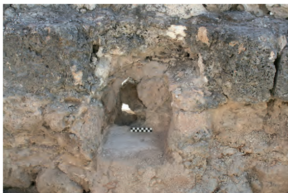
Fig. 63: Lienzo 1, parapeto, interior. Hueco resultante de la extracción de gárgola medieval (nº 2) reaprovechado para la ubicación de una aspillera postmedieval.
