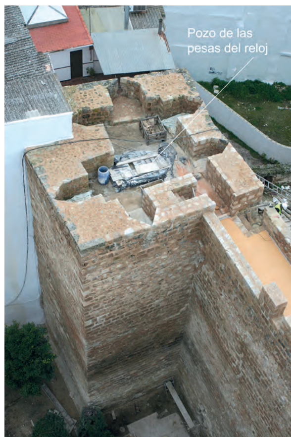
Fig. 9: Torre 1, en un momento avanzado de las obras de 2019-2020. Desmochada en el siglo XIX, conserva parte de las Cámaras de tiro y el arranque de la escalera de subida a la terraza. En el centro se abrió, en el siglo XVIII, un pozo para las pesas de un reloj público.
