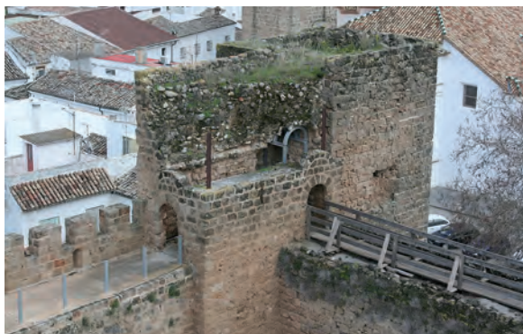
Fig. 26: Torre 3. Estado anterior a las obras, con desmantelamiento parcial ejecutado en 1977 como previo a una reconstrucción inconclusa que no se ha culminado hasta la intervención de 2019-2020.
