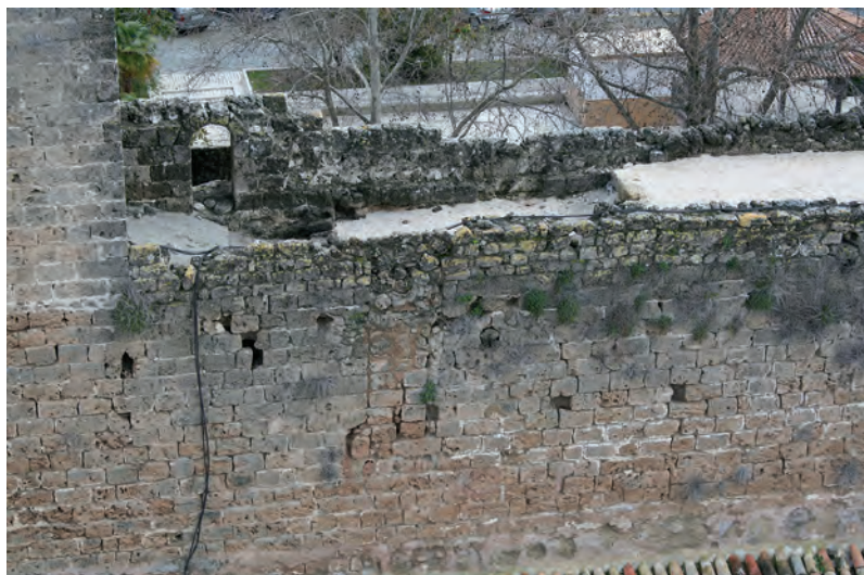
Fig. 42: Panorámica general del paradós del Lienzo 1, antes del inicio de los trabajos, con una discordancia edilicia evidente en relación al resto del paramento de la muralla.
