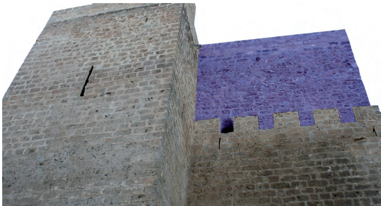
Fig. 56: Ampliación de la Torre 3, marcada en color, que monta sobre el Lienzo 3 y fosiliza cinco merlones originales medievales, parapeto completo y dos aspilleras.
