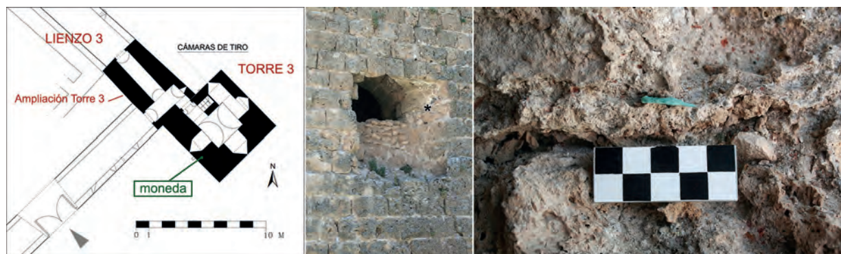
Fig. 124: Localización exacta del hallazgo del real de vellón de Enrique II en el grueso de la obra de la Torre 3. Sin el daño histórico que presentaba la aspillera de la Cámara de tiro D (foto del centro), que deja expuesto el núcleo interno de la estructura medieval, su recuperación hubiera sido prácticamente imposible.
