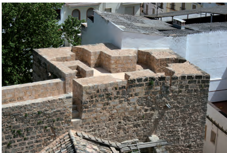
Fig. 81: Aspecto final de la Torre 1, tras su consolidación formalizando la cota máxima conservada del desmochado practicado en el siglo XIX. Se reconocen las distintas cámaras de tiro, así como las escaleras de acceso a la terraza y las de conexión con el Lienzo 8. La gárgola de evacuación de aguas pluviales se ha incorporado como necesidad durante las obras de 2019-2020.
