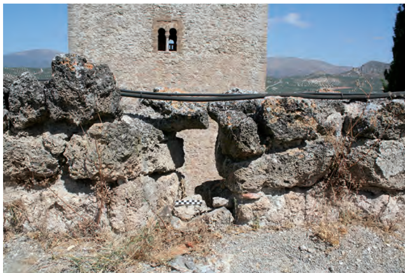
Fig. 55: Lienzo 1, paradós, aspillera 2. Es la mejor conservada de este paradós, con parte de la bovedita de cubierta. Estado previo a la intervención.
