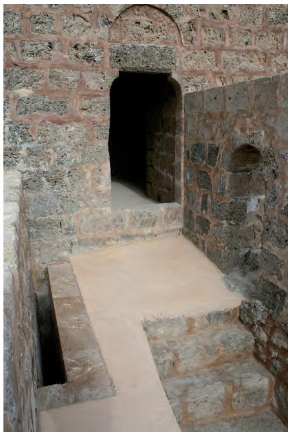
Fig. 50: Acceso a la Torre 2 desde el adarve del Lienzo 1, con mortaja del rastrillo (izquierda), acceso a la ladronera (derecha) y un tramo de la escalera doble del acceso directo desde el interior de la fortificación. Estado final previo a la instalación de protecciones de seguridad. Se puede observar la entrada muy elevada al interior de la torre y la pendiente del pavimento del adarve, reflejo del medieval infrayacente.
