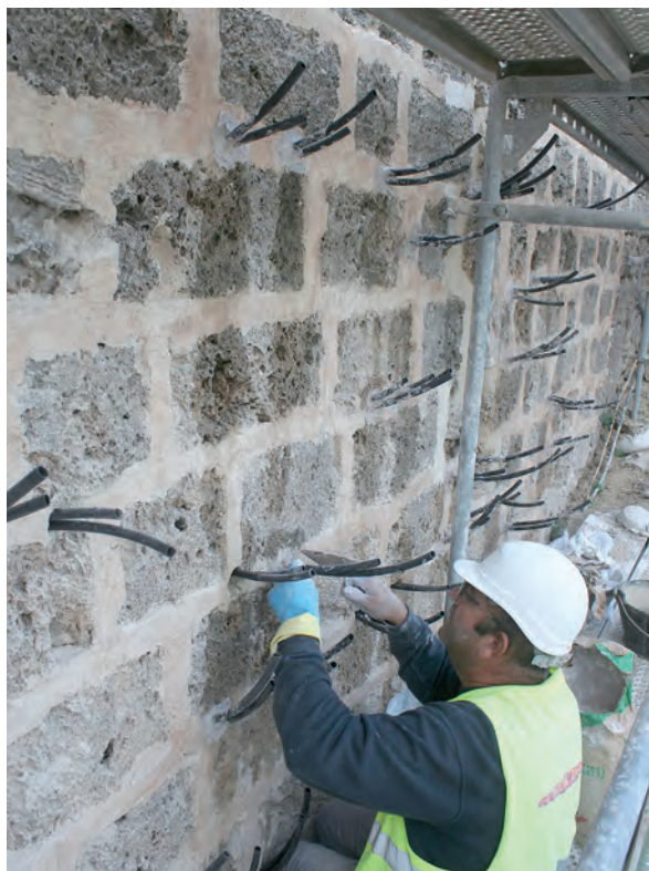
Fig. 32: Lienzo 1, interior. Ejecución de cosidos estructurales.
