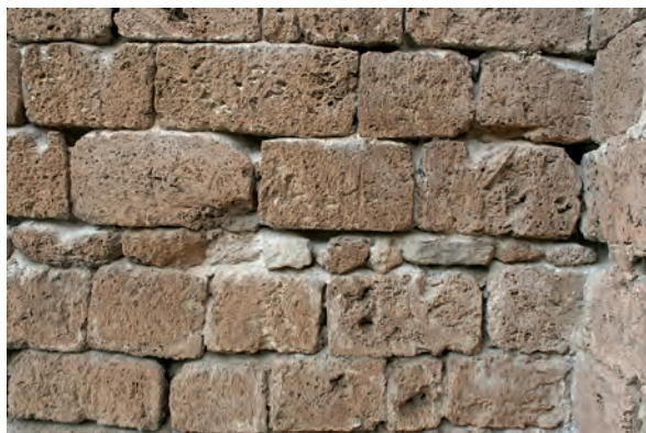
Fig. 39: Hilada de nivelación, discordante con la modulación media. Lienzo 2, exterior.
