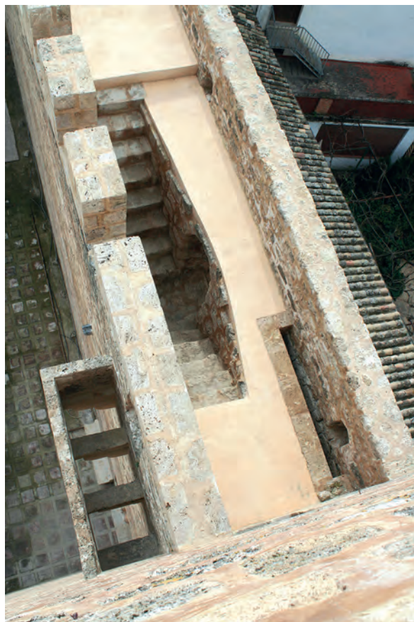
Fig. 12: Detalle del extremo del Lienzo 1 que entesta con la Torre 2, a la finalización de los trabajos de 2019-2020. De izquierda a derecha: ladrонера, parapeto aspillerado con merlatura, escalera doble, ranura del rastrillo y paradós aspillerado.
