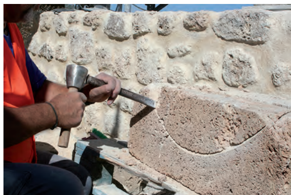
Fig. 33: Lienzo 2, adarve. Talla de bovedita para la reintegración formal de aspilleras.
