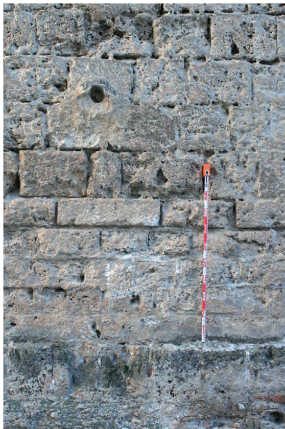
Fig. 41: Las cinco hiladas inferiores de las murallas y torres del sector intervenido están conformadas por sillería colocada por la tabla, y no por el canto, que es el estándar constructivo. Torre 3, lado c.
