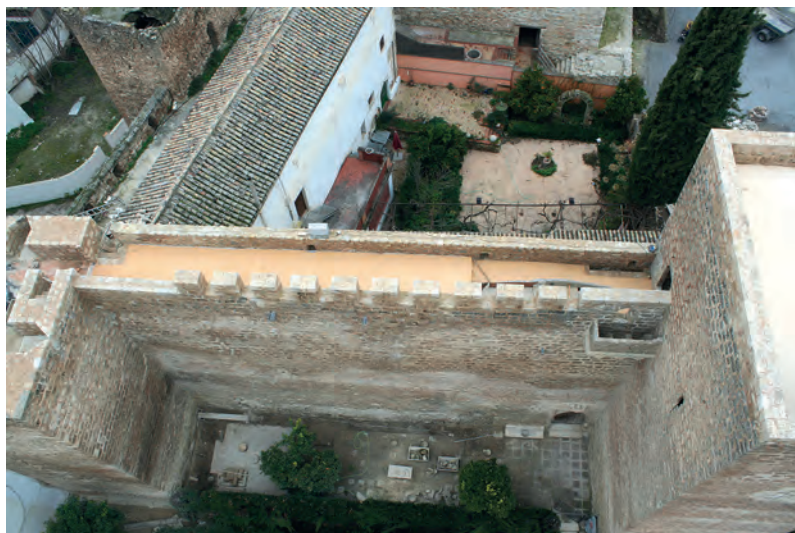
Fig. 10: Lienzo 1, que une las Torres 1 y 2, en un momento avanzado de las obras de 2019-2020. Conserva la puerta original medieval, defendida por rastrillo (del que se conserva la mortaja, pero no la reja) y ladronera.
