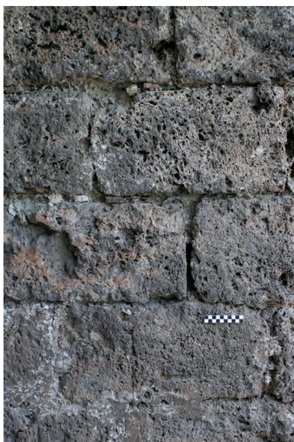
Fig. 37: Ejemplo de estereotomía cuidada en el corte y colocación de la sillería. Originalmente las juntas quedaban desdibujadas por un rejuntado muy ancho que aquí se ha perdido por erosión. Lienzo 2, exterior, a media altura.
