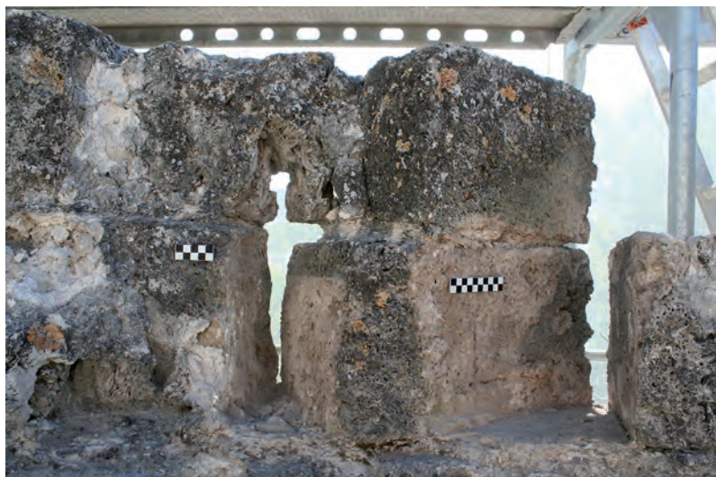
Fig. 53: Lienzo 1, parapeto, aspilleras 2 (a la derecha), correspondiente a la fase fundacional medieval. A la izquierda, aspilleras 2bis, solución de fortuna postmedieval posterior al desmantelamiento del parapeto. En proceso de limpieza y documentación, tras la retirada de parasitismo arquitectónico.
