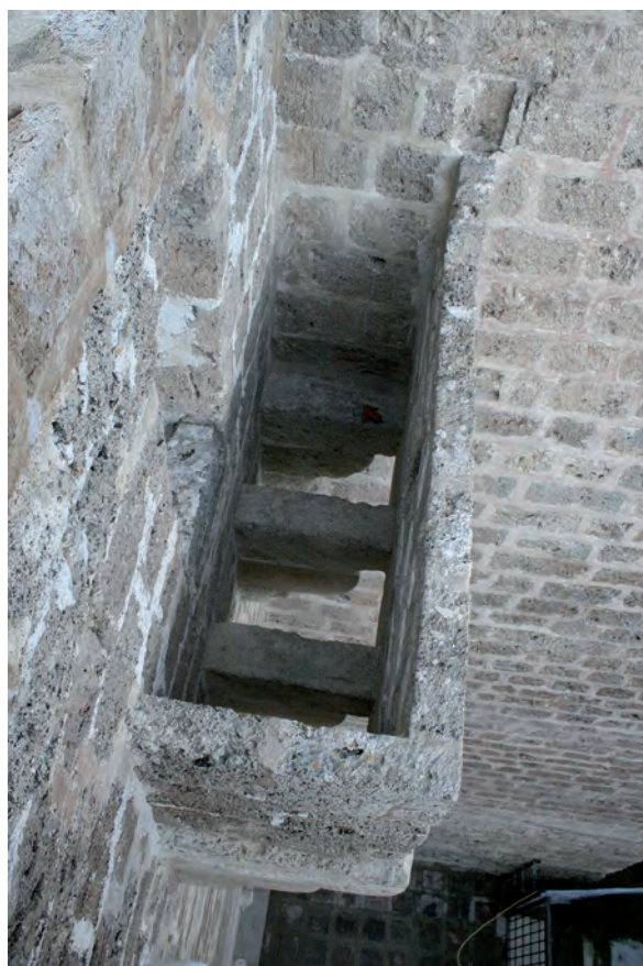
Fig. 70: Ladronera (Lienzo 1). Detalle de las ménsulas que sostienen la caja defensiva.
