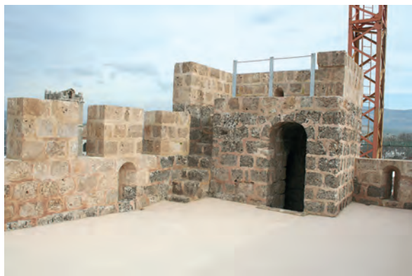
Fig. 17: Torre 2. Terraza. Aspecto final de la espécula, parapeto, aspilleras y merlatura.
