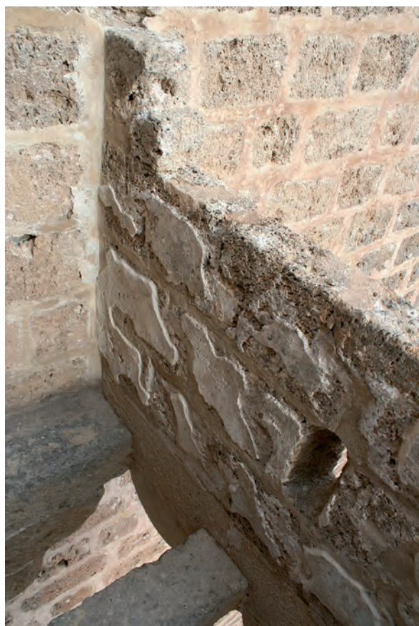
Fig. 72: Ladronera (Lienzo 1). Detalle del enlucido original interior con mortero de cal, tras su limpieza y consolidación.
