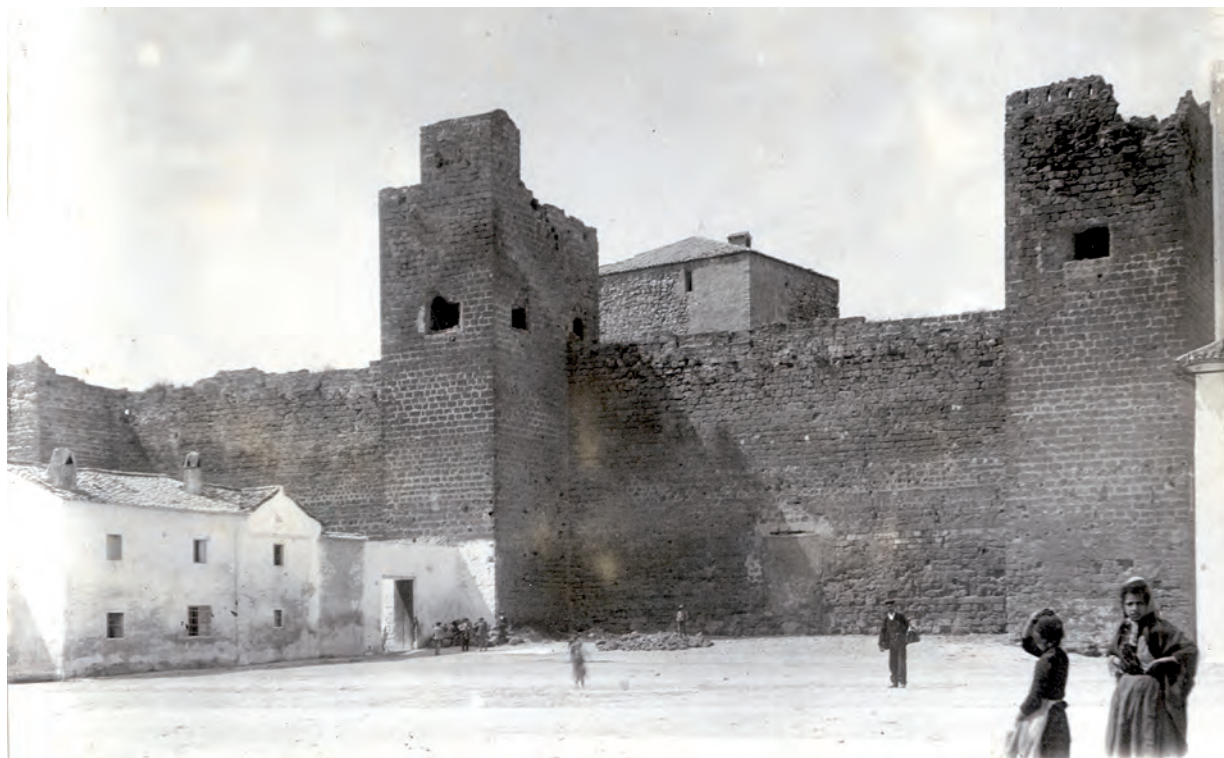
Fig. 8: Frente principal del castillo (T1+L1+T2+L2+T3) en una fotografía de finales del siglo XIX o principios del XX. Llamaman la atención los edificios adosados, la condensa de la puerta del acceso y el mal estado del terrado de la Torre 3 (a la derecha), con pérdida de volumen y parapeto aspillerado para fusilería (siglo XIX). Al fondo despunta el homenaje, con su cubierta de teja. Fuente: Archivo del CIP (Centro de la Imagen de Priego de Córdoba).
