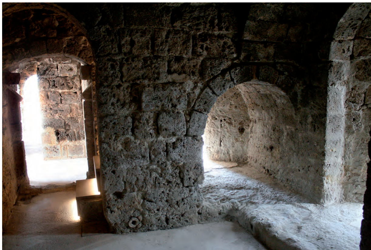
Fig. 21: Torre 3, interior. Aspecto general parcial desde una de sus cámaras de tiro.
