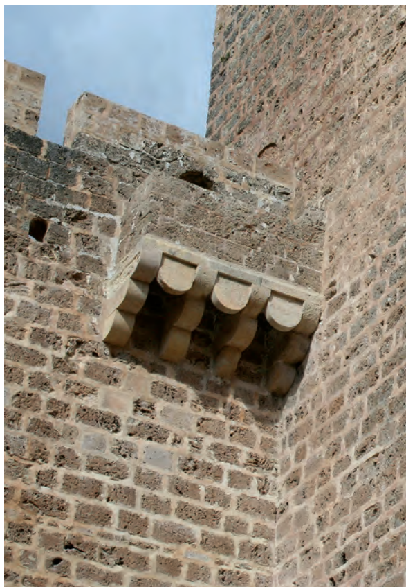
Fig. 69: Ladronera (Lienzo 1). Estado final.
