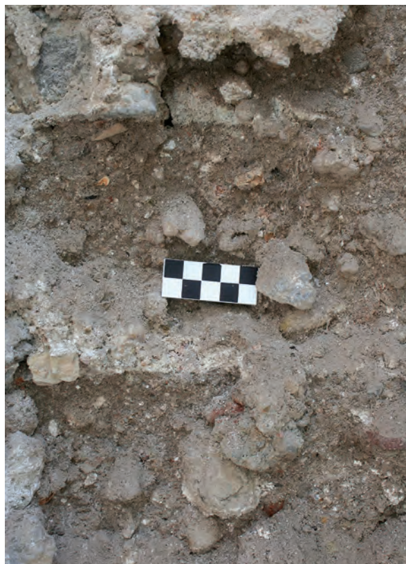
Fig. 77: Restos de tapial calicostrado identificado en el enteste de la muralla de la madina islámica y villa bajomedieval con la Torre 1 del castillo.
