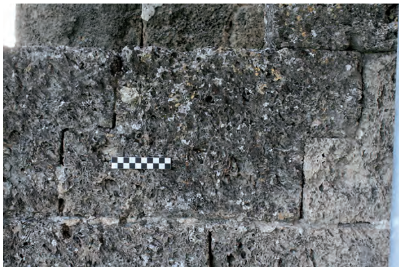
Fig. 71: Ladronera (Lienzo 1). Detalle de la sillería engatillada de su parapeto.
