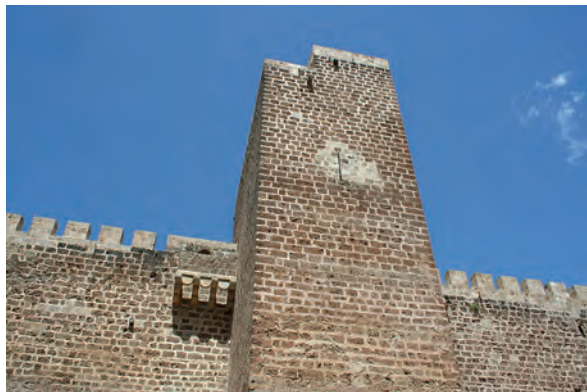
Fig. 14: Torre 2, que intercepta el paso entre los Lienzos 1 (con ladronera) y 2. Al término de los trabajos de 2019-2020.
