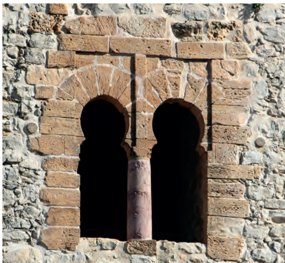
Fig. 6: Torre del Homenaje (siglo XIII). Detalle de ajimez tras la intervención de 2016-2017.
