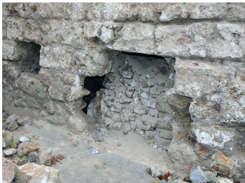
Fig. 121: Lienzo 3, exterior (año 2009). Posible minado en proceso de reintegración volumétrica. Inédito.
