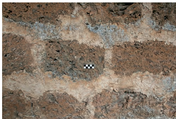
Fig. 35: Rejunto original medieval conservado en distintos paramentos del sector intervenido. Torre 2, lado a.
