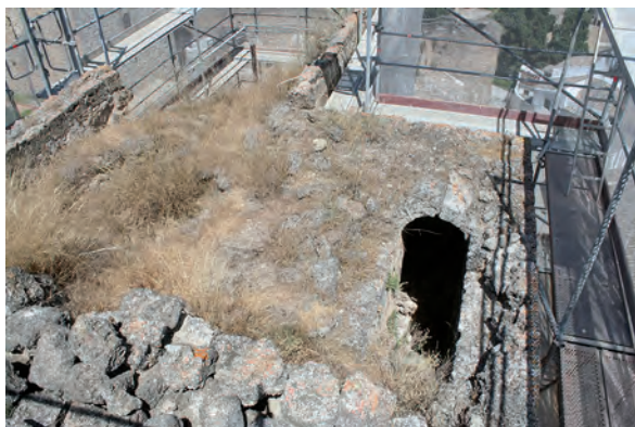
Fig. 23: Torre 3, terraza. Aspecto desolador que mostraba antes del inicio de los trabajos, con pérdida del garitón de salida. Los parapetos, aspilleras y pavimentos se hallan arrasados, y se observa una merma importante en la masa del volumen de ampliación de la torre sobre el Lienzo 3 (ángulo superior izquierdo).
