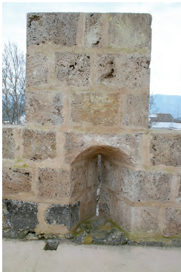
Fig. 19: Torre 2. Adarve. Ejemplo de parapeto, aspillera y merlatura recuperados conforme al registro arqueológico documentado.
