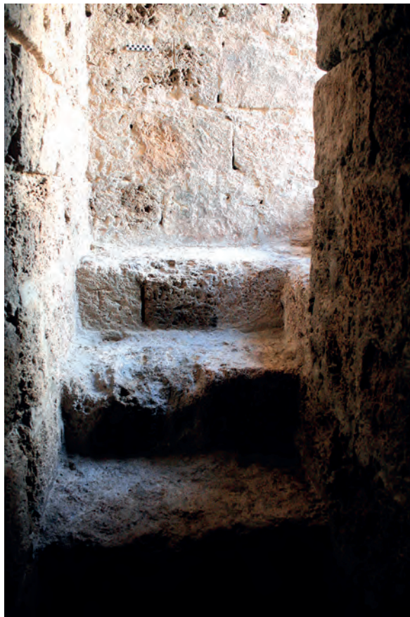
Fig. 16: Torre 2. Escaleras originales de acceso a la terraza.
