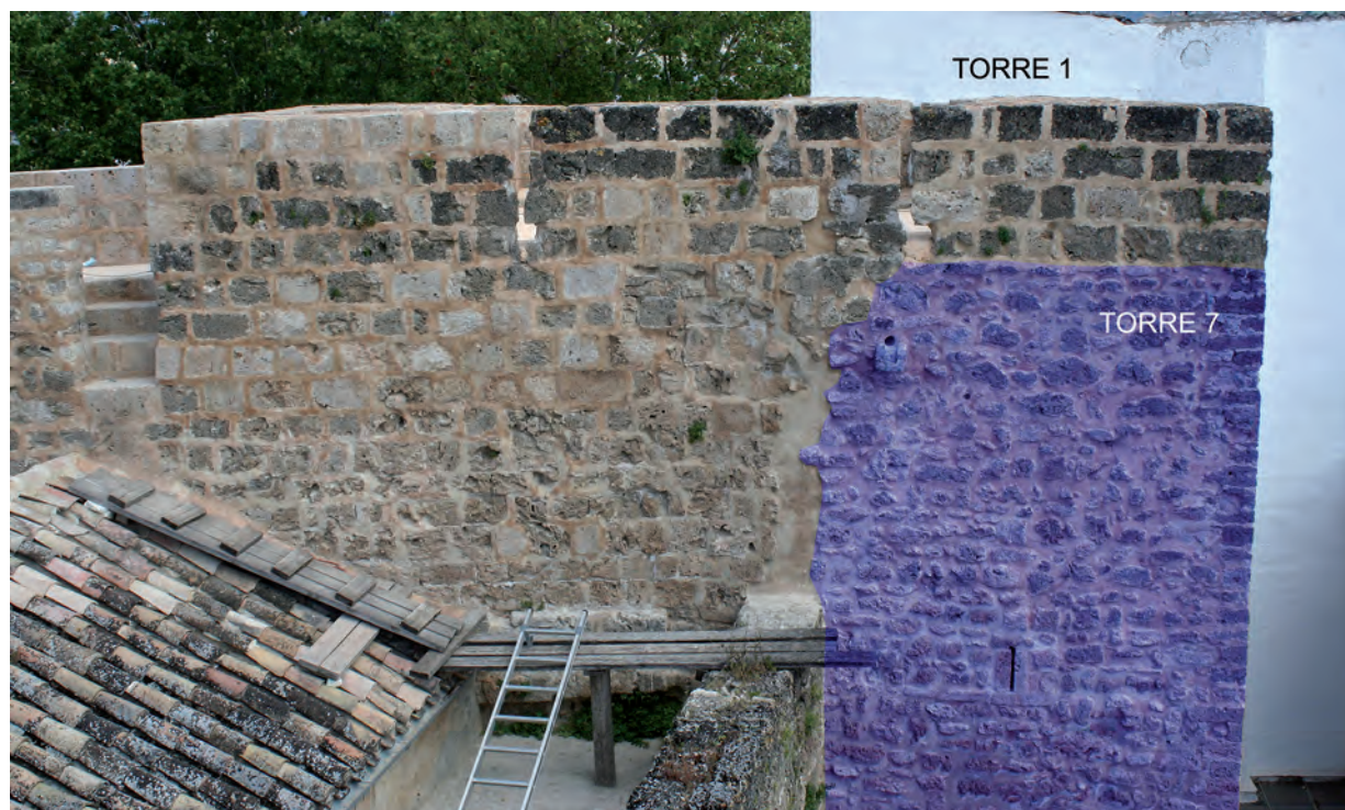
Fig. 83: Relación estratigráfica muraria entre la Torre 1 y la Torre 7, parcialmente parasitada por la primera. En primer término, el adarve del Lienzo 8, a una cota sensiblemente inferior (c. -386 cm) a la del adarve del Lienzo 1.
