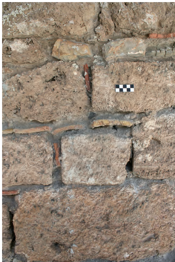
Fig. 38: Ejemplo de estereotomía descuidada en el corte y colocación de la sillería, con desnivelaciones y recalces abundantes. Su empleo estaba destinado a sectores menos visibles de la obra. En todo caso, el rejuntado tendía a regularizar el grosero aspecto original, ahora evidenciado por erosión de los morteros. Lienzo 2, interior, parte superior de la muralla.
