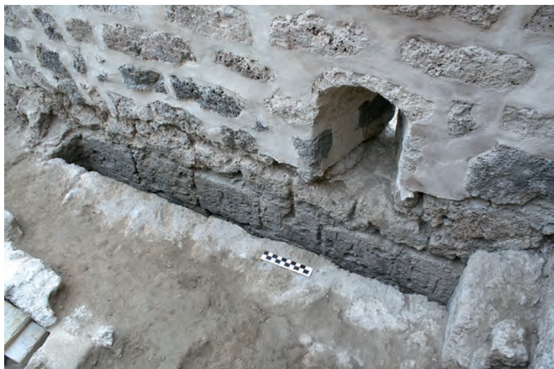
Fig. 74: Lienzo 1, adarve. Mortaja del rastrillo tras su limpieza, que queda enrasada con el pavimento medieval fundacional, a excepción de los lados cortos. Las aspillera inmediata corresponde al paradós.
