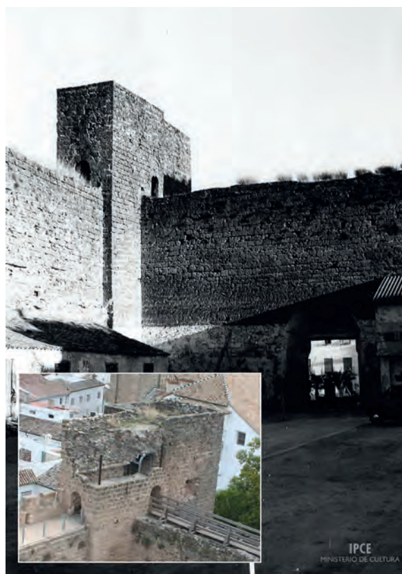
Fig. 3: Imagen en torno a 1977 de la Torre 3, afectada por una grieta estructural, que fue desmochada y solo parcialmente reconstruida ese mismo año. En el recuadro, estado previo a las obras de 2019-2020 que han recuperado la volumetría original. Foto b/n: Archivo IPCE. Ministerio de Cultura.
