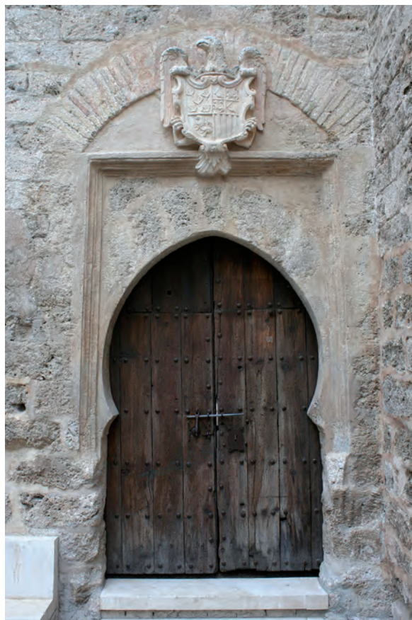
Fig. 68: Puerta original de entrada al castillo (Lienzo 1), cuya vertical está defendida por una ladronera. El escudo es postmedieval. Estado final.
